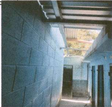
Foto1: Sustrucción de lamina, por lamina troquelada aluzinc calibre 26 en baños.
