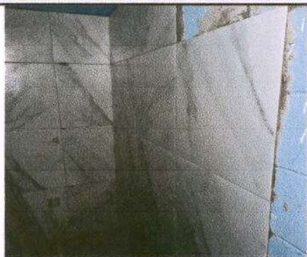
Foto 7: Sustrución de azulejo
