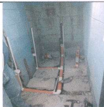
Foto 6: Sustrucción de inodoro por mingitorio
