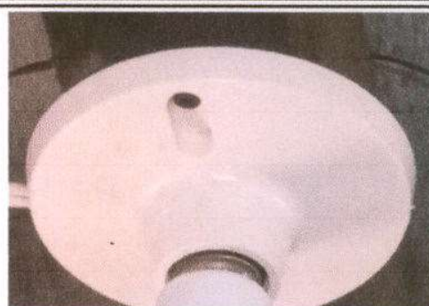
Foto 8: Sustrución de focos ahorradores.
