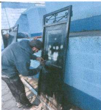
Foto 3: : Mantenimiento a estructura (lijado, cambio de tubo, cepillado, aplicación de pintura)
