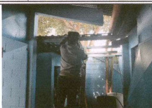
Foto 2: Sustrucción de estructura de soporte de metal por metal en baños
