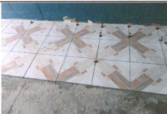
Foto 4: Sustrucción de piso de cemento liquido por cerámico.
