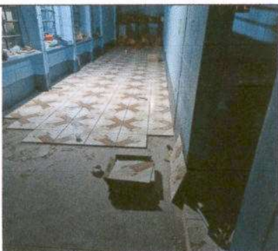
Foto 5: Sustrucción de piso de torta de concreto por piso cerámico.
